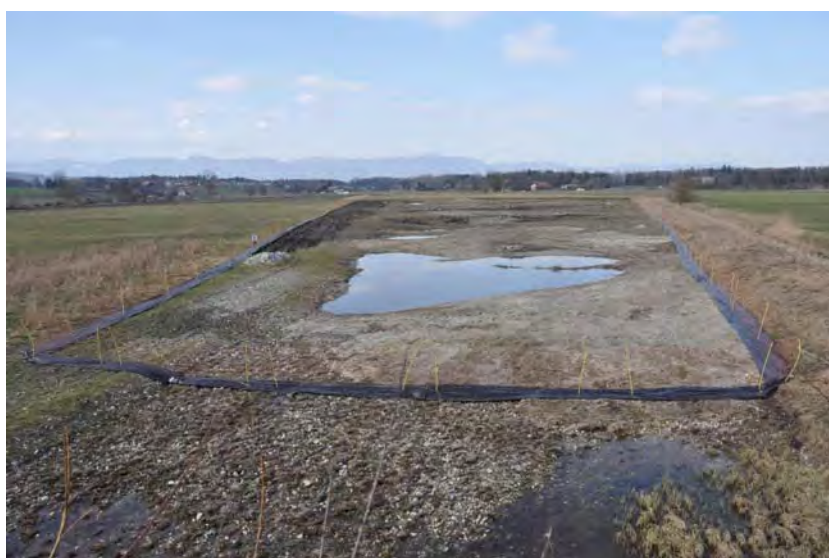
Abb. 4: Um zu verhindern, dass der Zaun zu schnell einwächst, wodurch die Spannung abfällt und der Zaun somit nicht mehr funktionstüchtig ist, wurde im Fraubrunnenmoos ein Bändchengewebe ausgelegt und mit Nägeln befestigt (Lieferant Hortima Baumschulbedarf, 0,85 x 200 m). (Foto: S. Bachmann)
