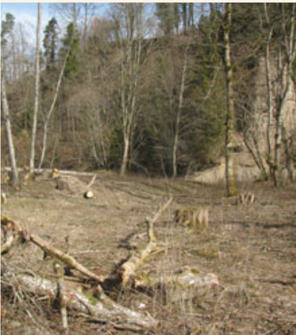
Ein Standort mit invasiven Pflanzen wird hier zu einem Seitengewässer umgewandelt.
